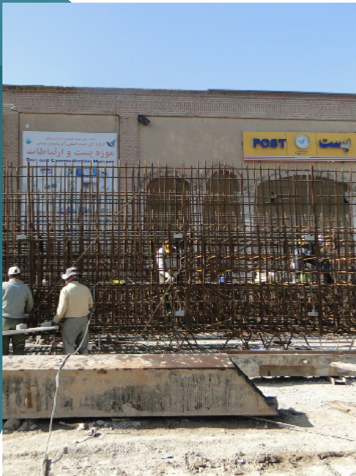
شکل ۳-۴۱- ایستگاه S08 خط ۲
